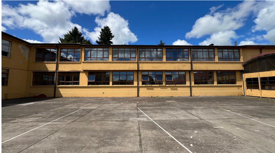
Cambio termo panel Sede Victoria
